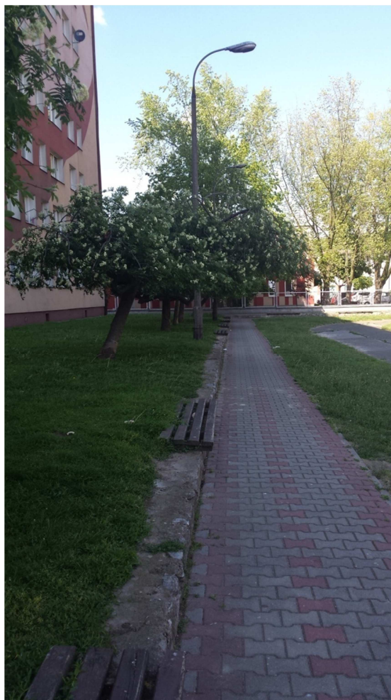
Widok na ciąg pieszy i murek oporowy zlokalizowany przy zachodniej granicy terenu inwestycji.
